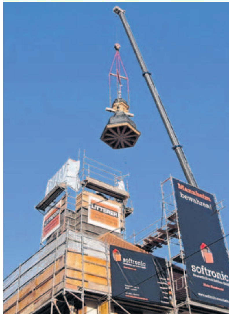
Am Haken eines 130-Tonnen-Krans schwebt der restaurierte Turmhelm des historischen Seckenheimer Rathauses an seinen Platz.
